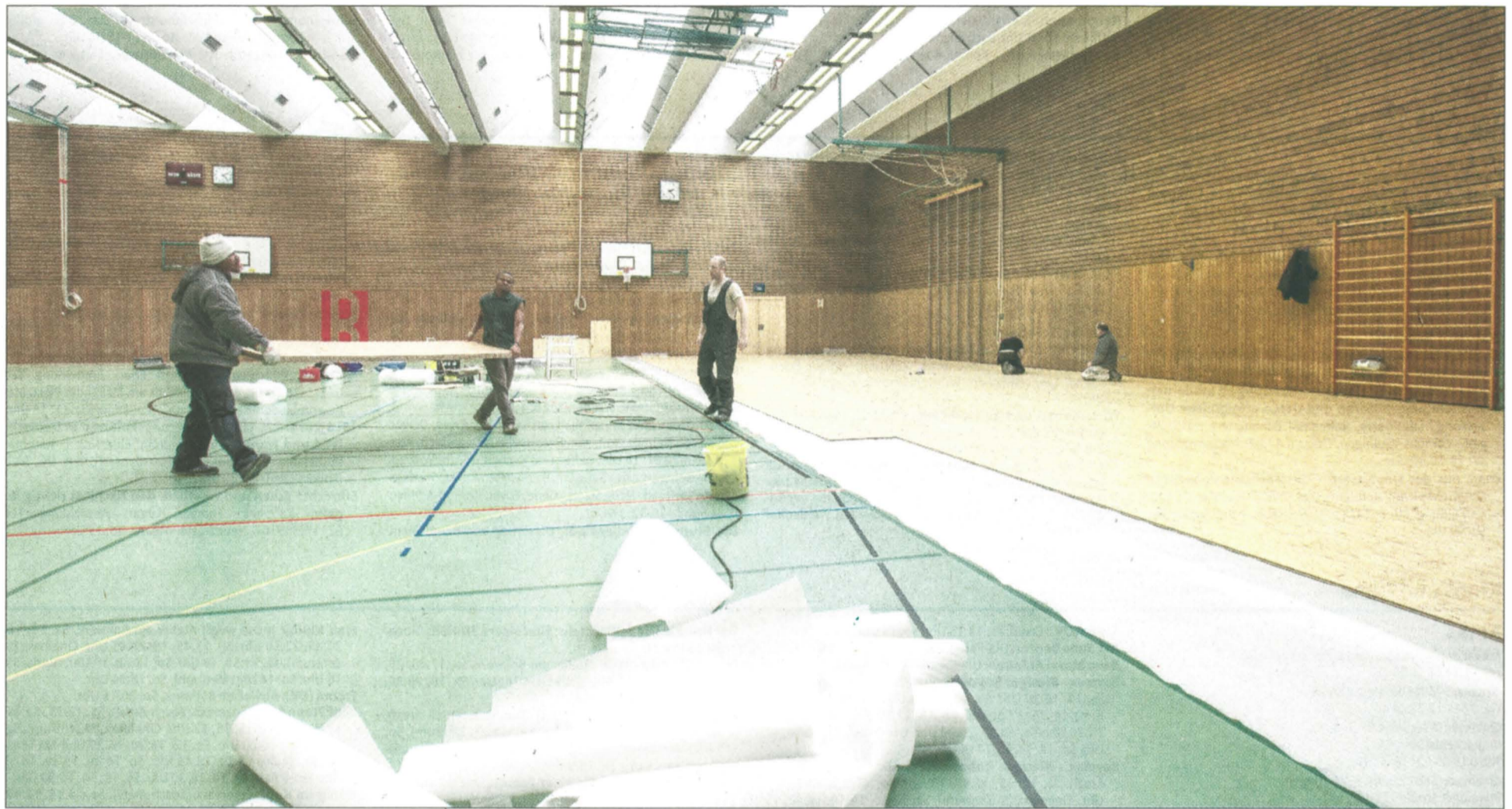
Die Sporthalle wird zu einer Unterkunft für 100 Flüchtlinge: Mit den Arbeiten wurde bereits begonnen. Zwei Drittel werden Schlafräume, das dritte Drittel dient als Gemeinschaftsraum. Fotos: E. Layher
