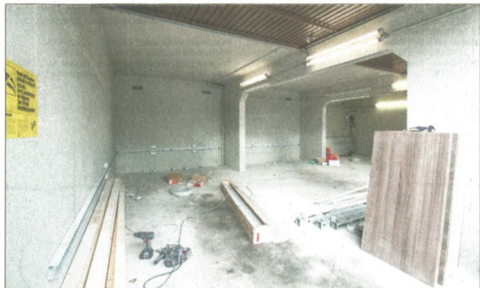
Ergänzen die drei Wasch- und Kochcontainer, die neu aufgestellt wurden: Die drei Garagen am Rande des Handballfelds. Auch hier laufen die Umbauten auf Hochtouren.
